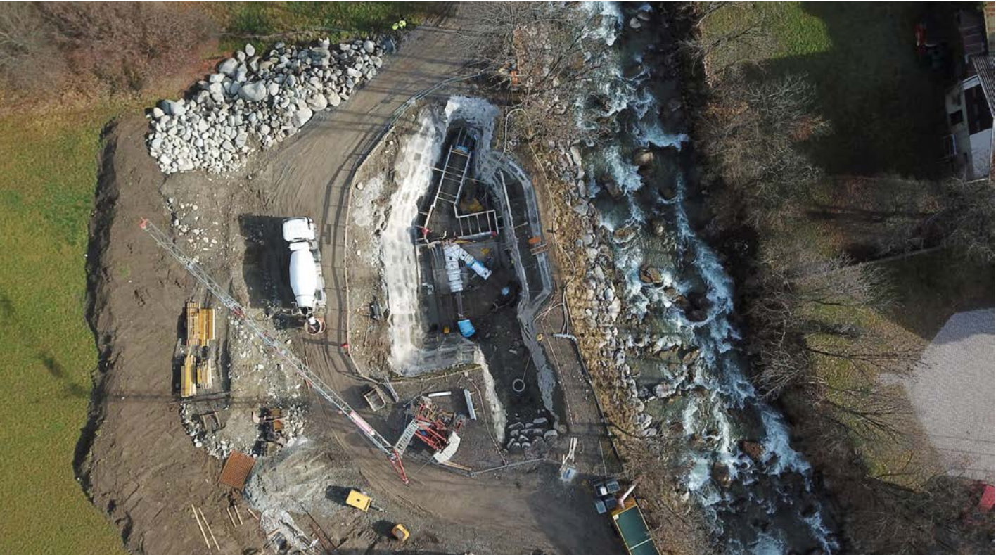
Erdbau Vereinigungsbauwerk KW Sellrain, AT
