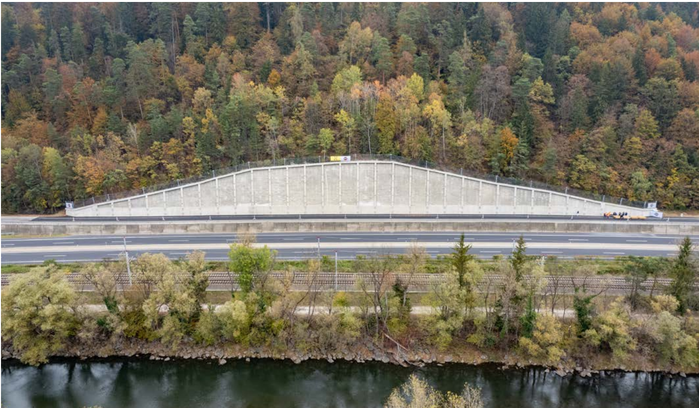
Sanierung Klagemauer, Frohnleiten, AT
