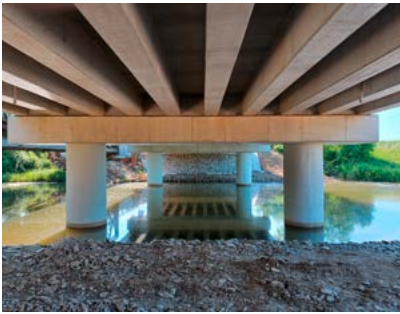
Rekonstruktion Brücke Stretava, SK
