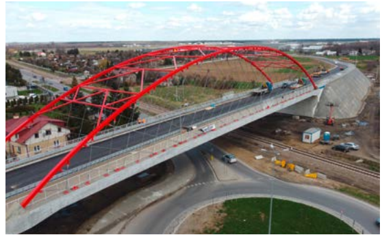
Straßen- und Bahnviadukt, Mielec, PL
