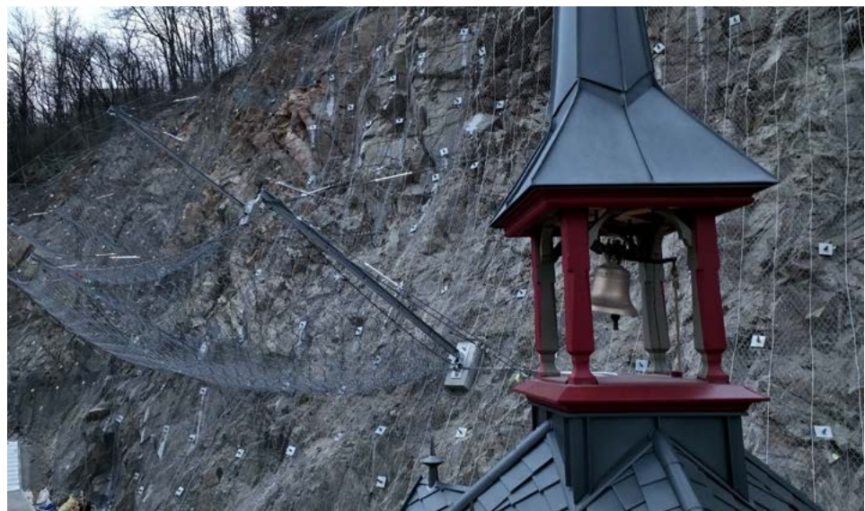
Felssicherung Brno, CZ
