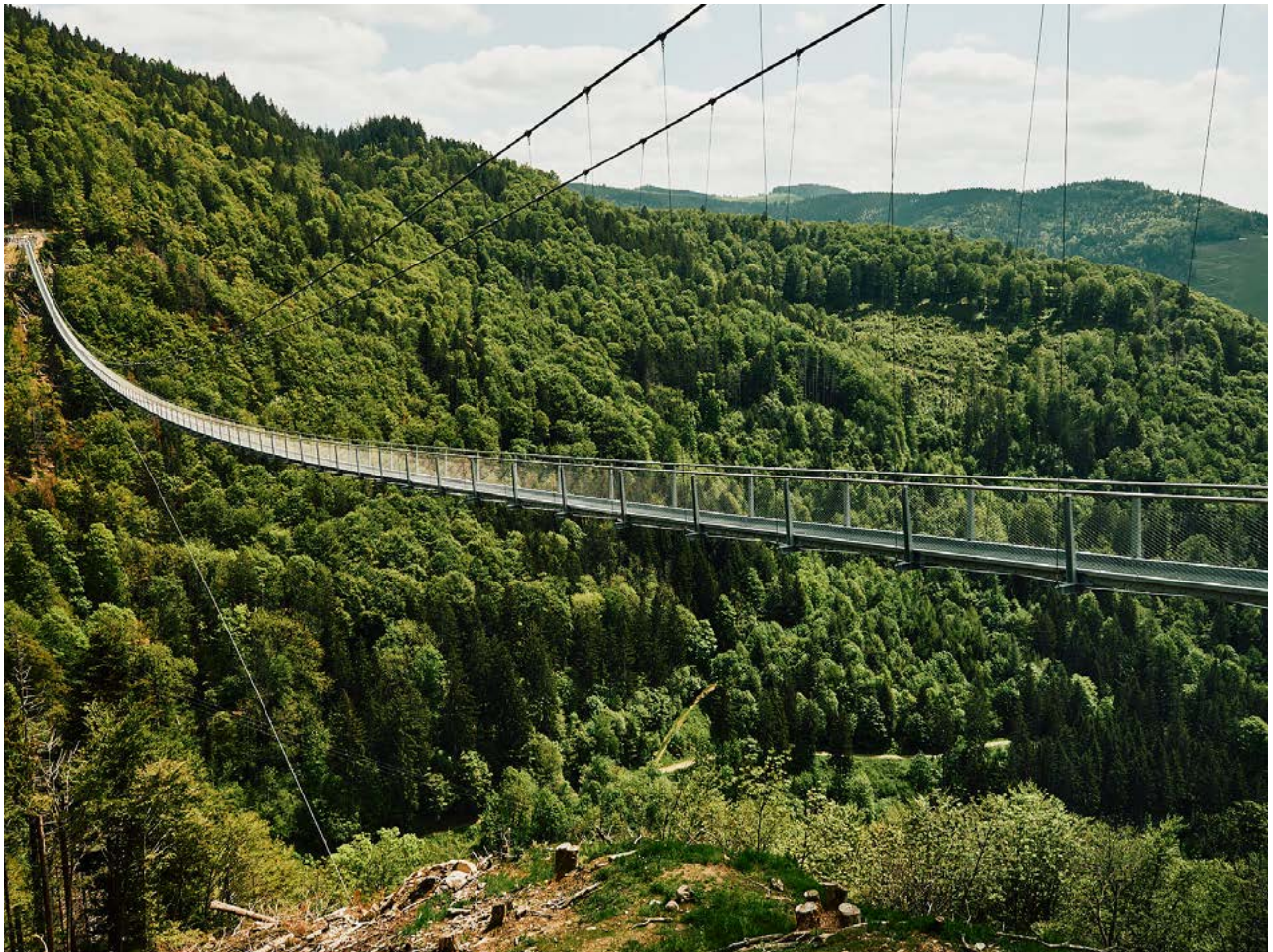
Hängebrücke Todtnau, DE
