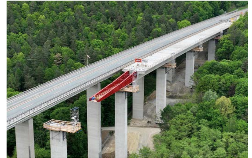
ARGE Talübergänge S31, Siegraben, Österreich
