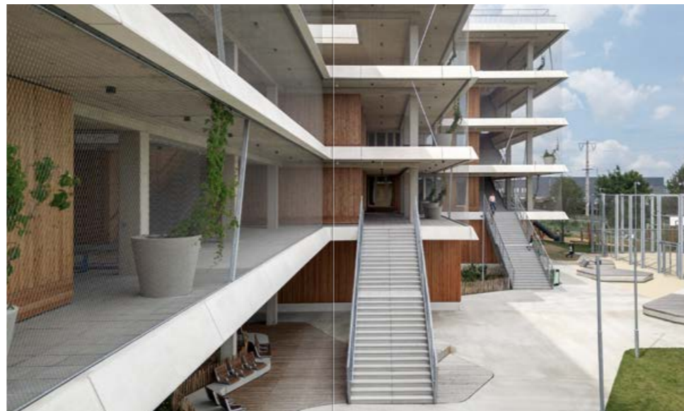
Schule Leopold-Kohr-Straße, Wien, Österreich
