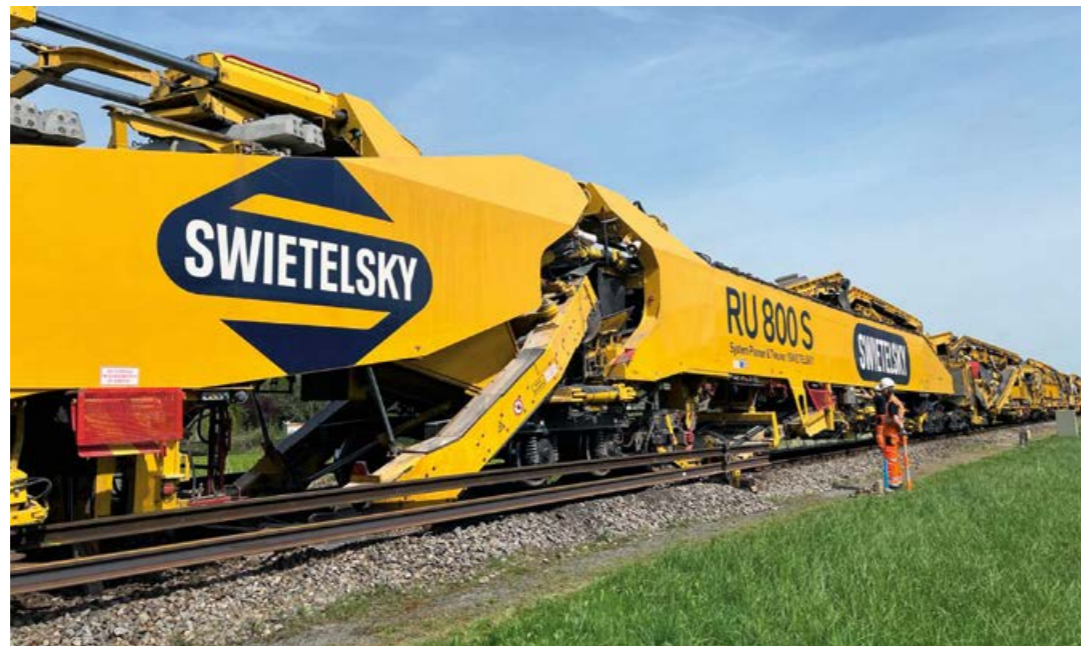
Generalsanierung Riedbahn, Deutschland
