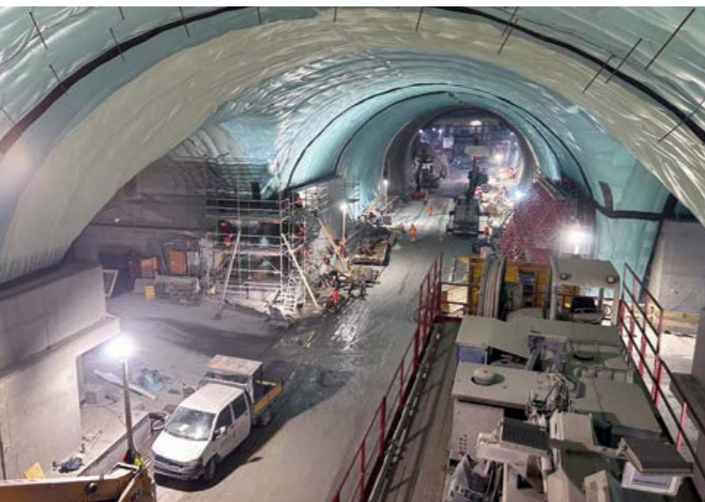
Basistunnel Semmering, Steinhaus am Semmering, Österreich
